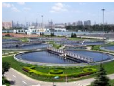
北京市下水処理場
